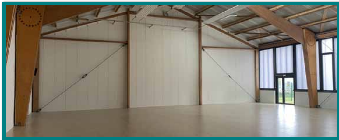
Les travaux de rénovation au Léo Lagrange avancent avec la pose d'un nouveau sol et un rafraîchissement des peintures murales.
