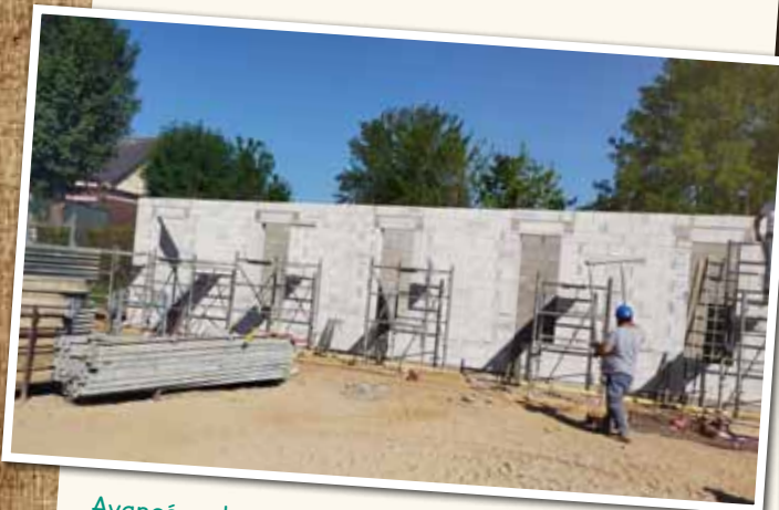
Avancée des travaux de la Maison de Santé Pluridisciplinaire avec le coulage de la dalle du bâtiment et l'élevation des différents murs.
